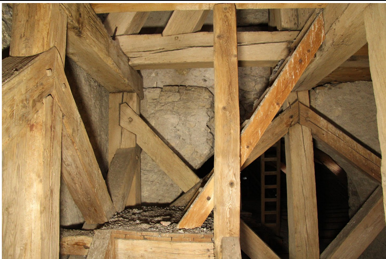
Štenýřová konstrukce ve druhém patře věže v pohledu od západu. Foto: Jaroslav Skopec, 2018.
