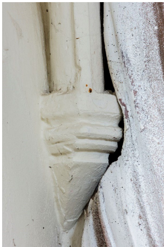
Severozápadní konzole v pohledu od jihu. Foto: Marta Pavlíková, 2022.
