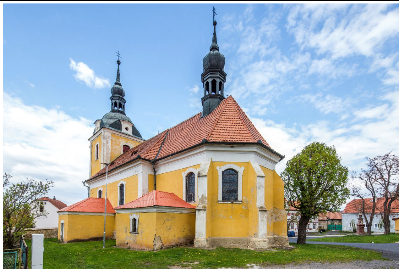
Celkový pohled od jihovýchodu. Foto: Marta Pavlíková, 2022.
