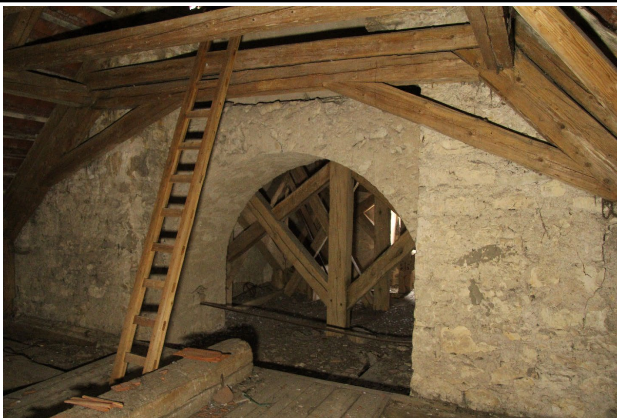
Východní strana věže na úrovni druhého patra obracející se do krovu. Foto: Jaroslav Skopec, 2018.
