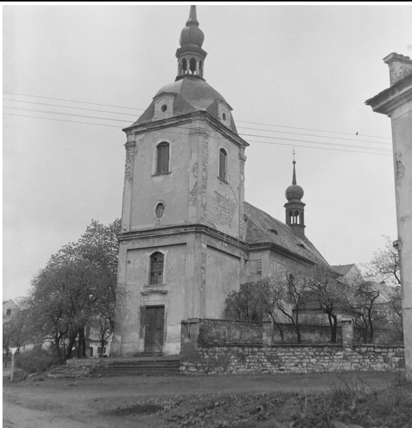
Celkový pohled od jihozápadu. Foto: 1963, sbírka negativů NPÚ ÚOP v Ústí n. L., sig. 8374.
