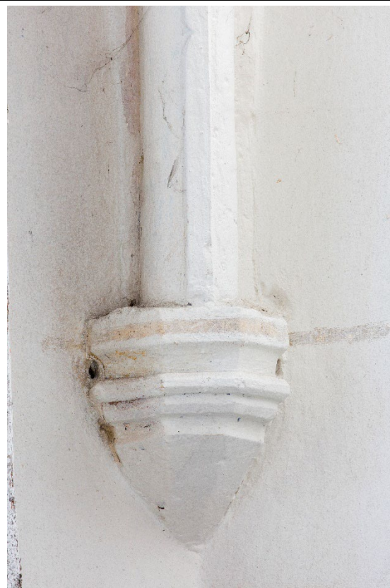
Východojihovýchodní konzole presbytáře v pohledu od severozápadu. Foto: Marta Pavlíková, 2022.
