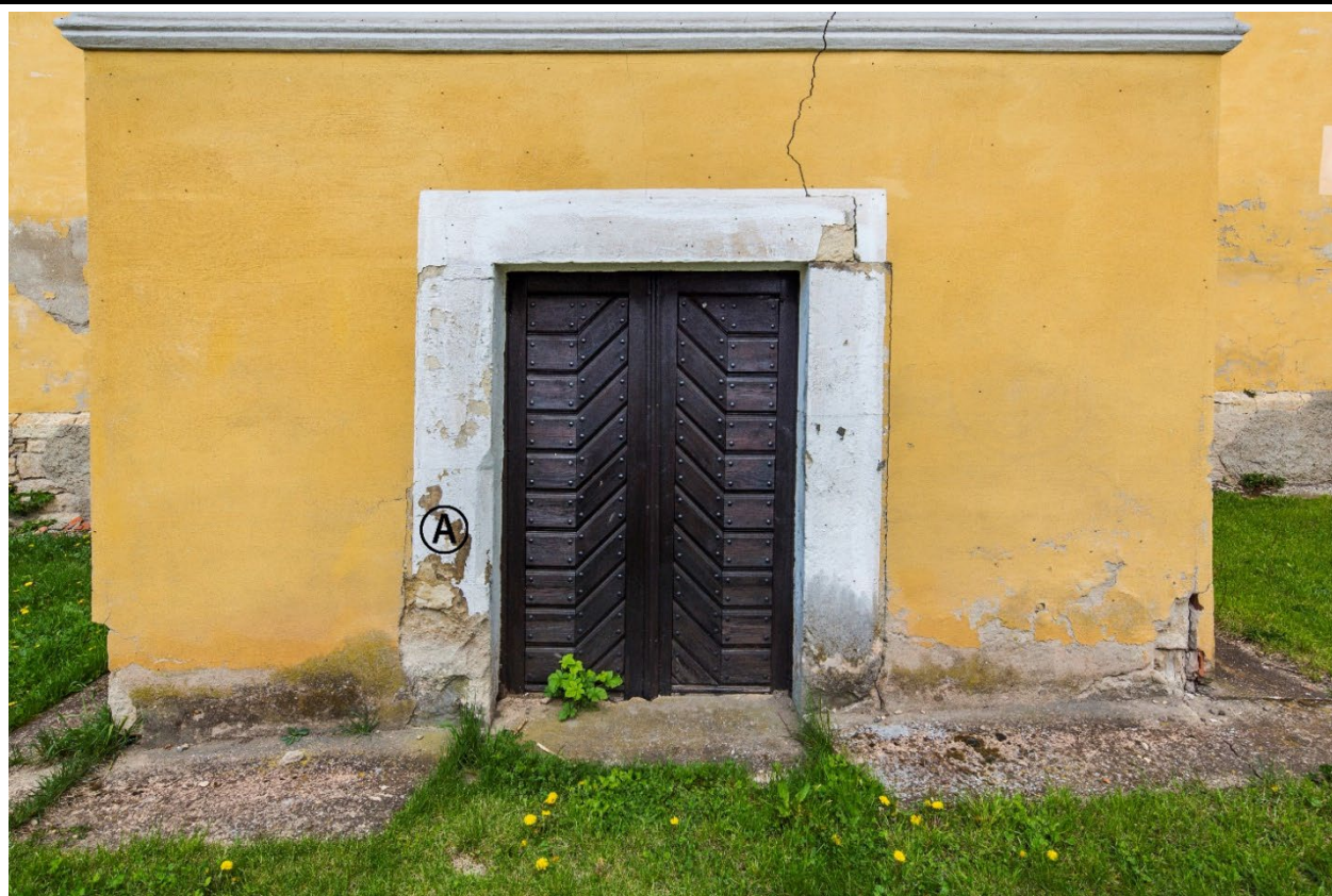
Jižní průčelí předsíně v pohledu od jihu. A – díl stojky ostění portálu s čelně sklopenou trojúhelnou ploškou náběžního štítku s vodorovnou čelní hranou. Foto: Marta Pavlíková, 2022.
