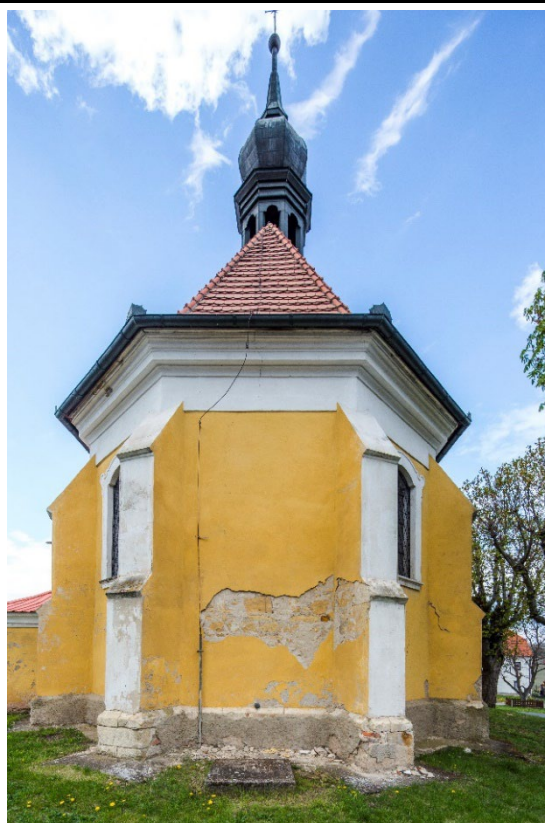
Východní průčelí presbytáře v pohledu od východu. Foto: Marta Pavlíková, 2022.
