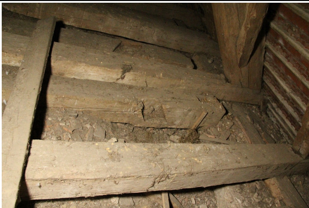
Zhlaví stropních trámů s dlaby dokládající jejich druhotné použití z krovu, pro nějž bylo káceno dřevo mezi lety 1543 a ž 1545.
