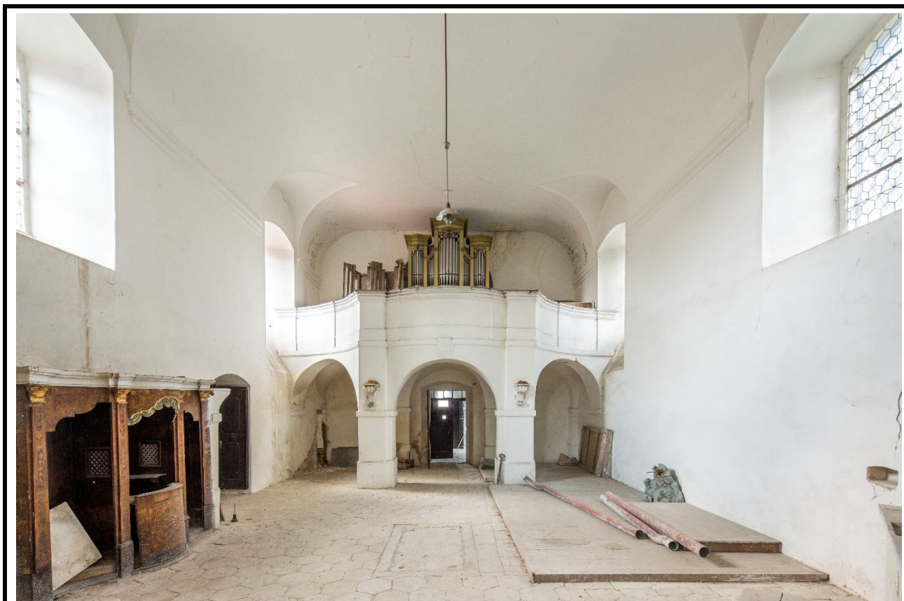
Interiér lodi v pohledu od východu. Foto: Marta Pavlíková, 2022.
