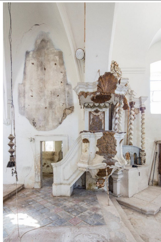
Jižní strana presbytáře v pohledu od severu. Foto: Marta Pavlíková, 2022.
