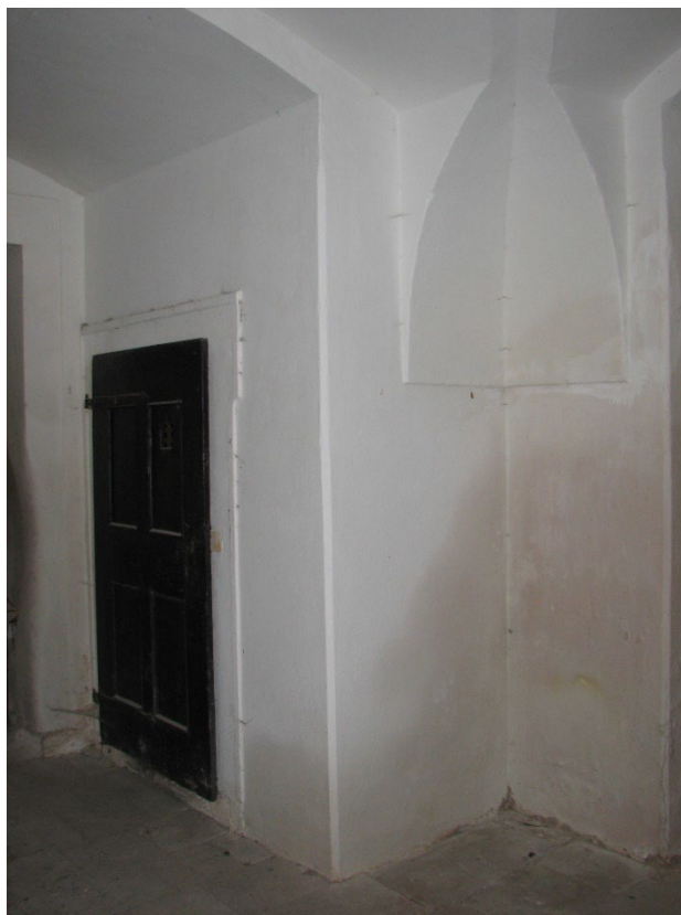
Interiér přízemí věže v pohledu od severozápadu se vstupem na točité schodiště. Foto: Tomáš Brož, 2009.
