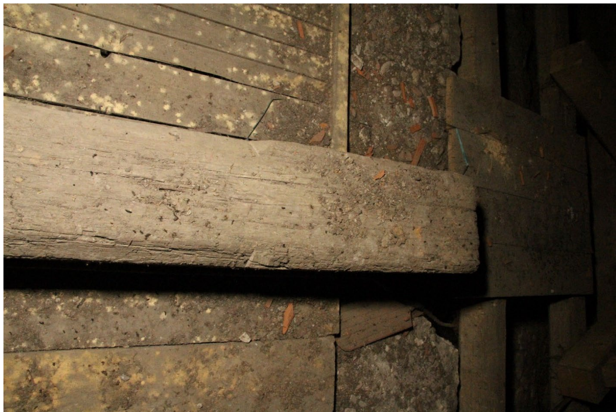
Zhlaví středního průvlatku krovu nad lodí s patrným ukončením náběžními štítky. Foto: Jaroslav Skopec, 2018.
