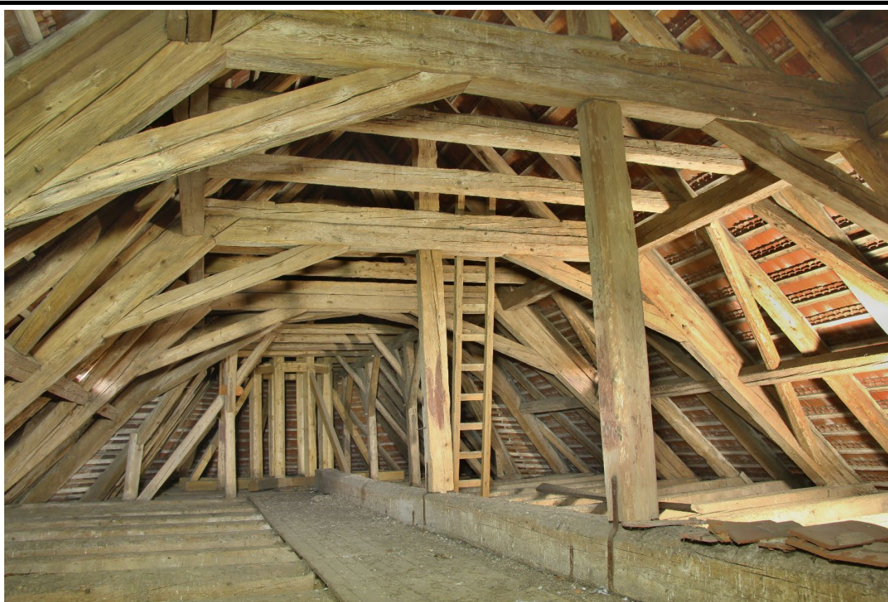
Průhled krovem lodi ve směru od západu. Foto: Jaroslav Skopec, 2018.
