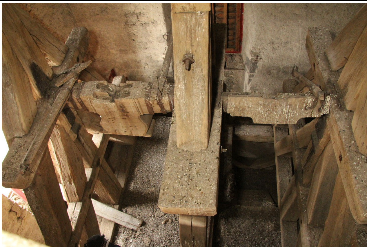
Zvonová stolice ve třetím patře věže v pohledu od jihu. Foto: Jaroslav Skopec, 2018.
